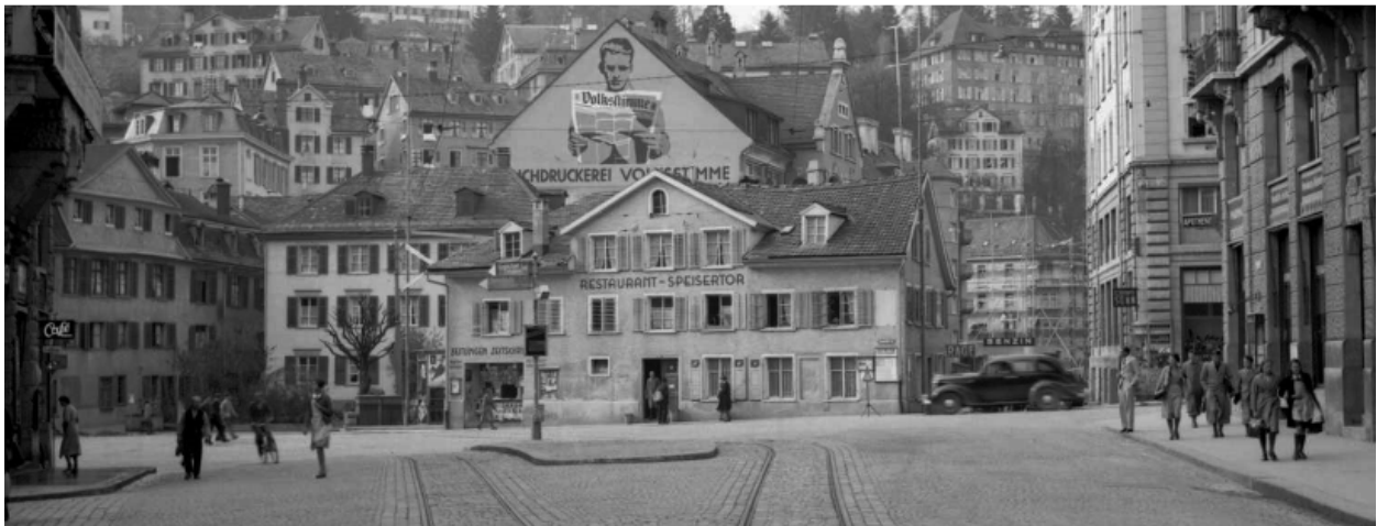
Burggraben Richtung Moosbruggstrasse, 9000 St. Gallen (1950)
