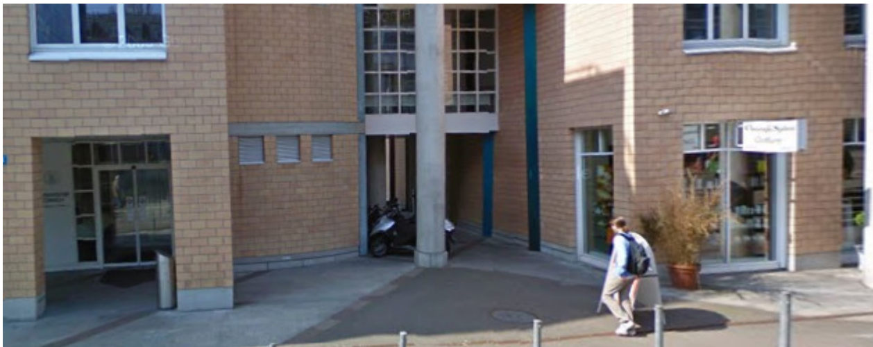
Plattenstr. 14 mit Passage zur Schönleinstr. u. zum Phoenixweg, 8032 Zürich (2009)
